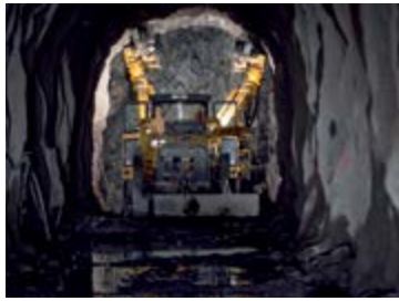
Berg- und Tunnelbau
